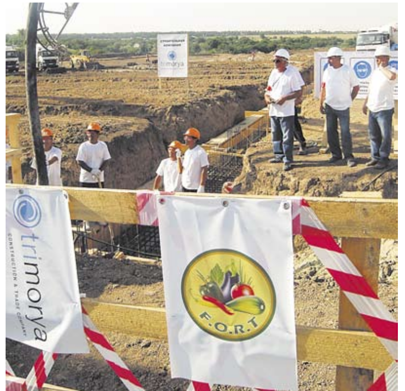
Строительство фруктово-овощного терминала «Ф.О.Р.Т.» было начато в августе 2010 года (на фото). В конце 2011-го была запущена первая очередь. В конце 2012-го между заказчиком «Аксай & Истамбул» и подрядчиком «Три моря констракшн и трейд компани» начались разногласия. Фото из архива N.
